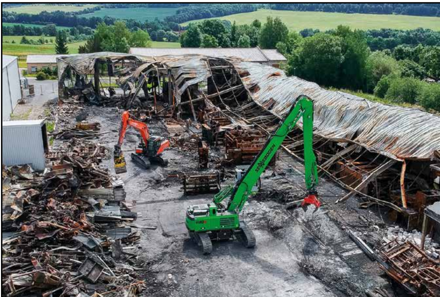
6698 Hermann Kathöler GmbH / Foto: Tim Kathöler / BHW Bausparkasse
