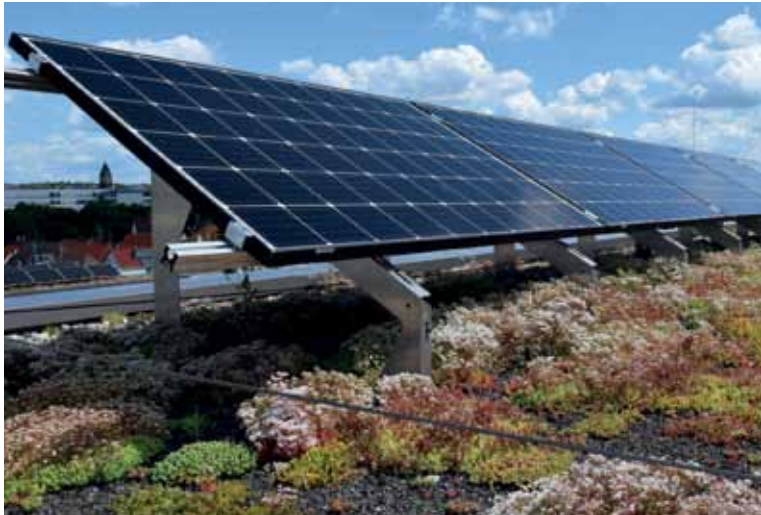
Solarmodule können direkt auf dem bepflanzten Dach installiert werden
