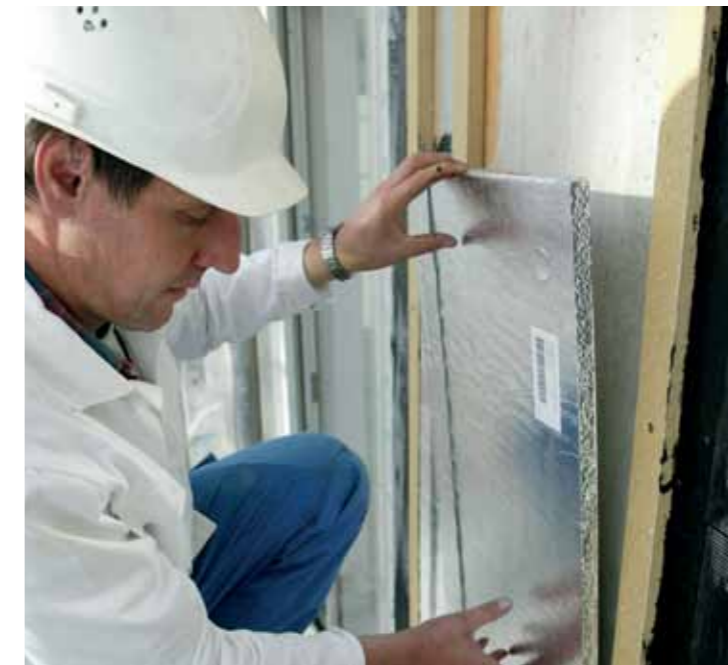
Dünnere dämmen – eine Vakuum-Dämmung spart wertvolle Fläche
