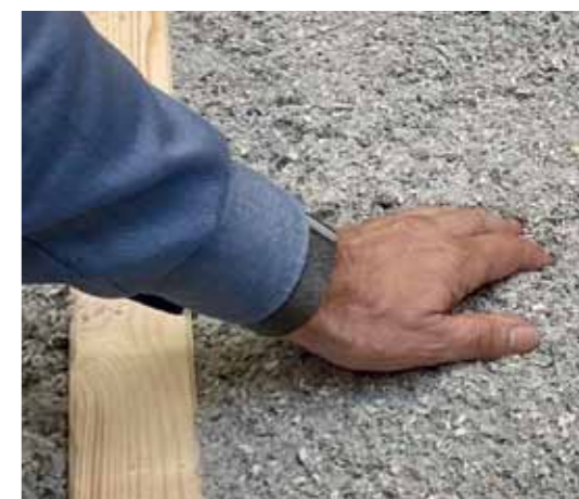
Gut isoliert: Aus Altpapier gewonnene Zellulosefasern
